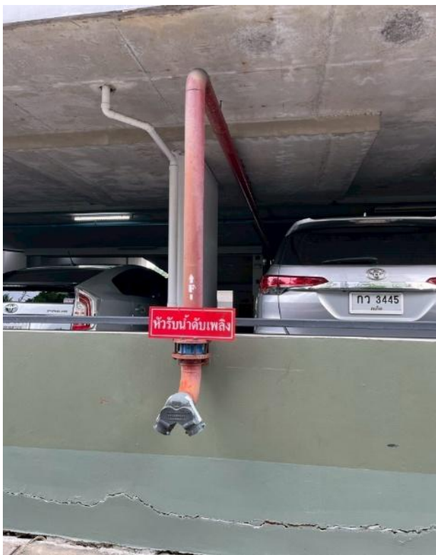
ภาพที่ 20 น้ำสำรองสำหรับดับเพลิงและหัวรับน้ำดับเพลิง
