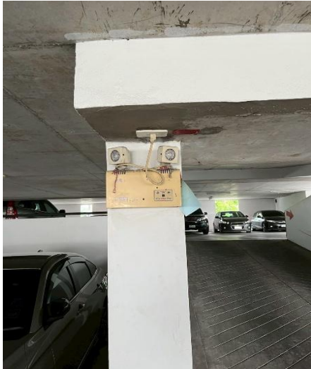
ภาพที่ 26 ไฟสำรองส่องสว่าง
