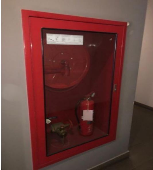
ภาพที่ 19 ตู้สายฉีดน้ำดับเพลิง
