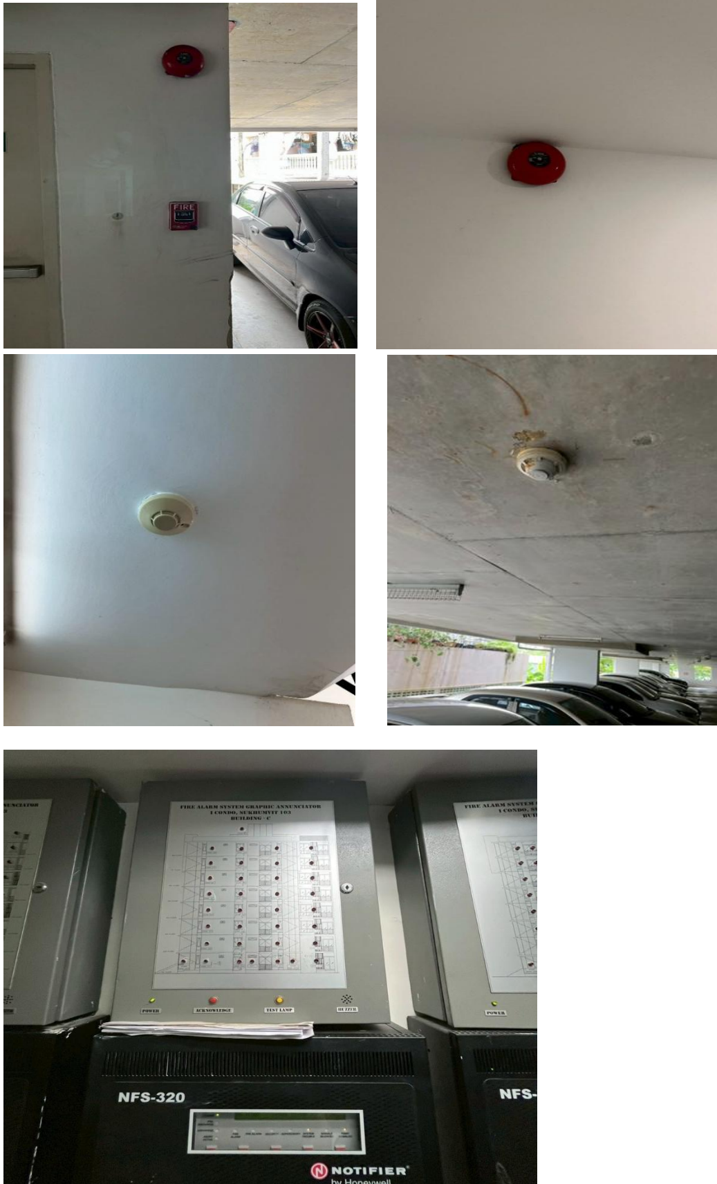
ภาพที่ 18 ระบบเตือนอัคคีภัย ภายในโครงการ
