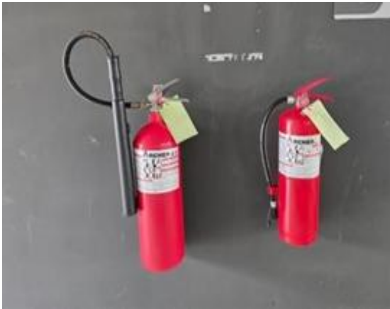
ภาพที่ 22 เครื่องดับเพลิงแบบมือถือ และการตรวจสอบ
