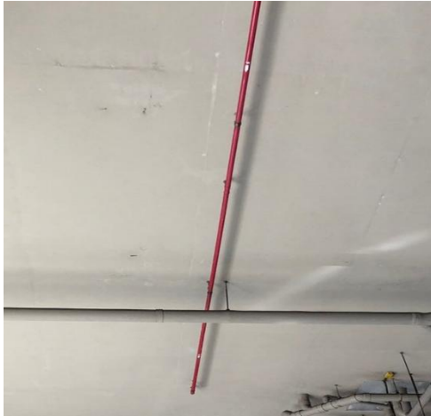
ภาพที่ 21 ระบบดับเพลิงแบบกระจายกระจายน้ำอัตโนมัติ
